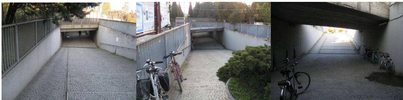
Foto n.1 sottopasso lato sud
